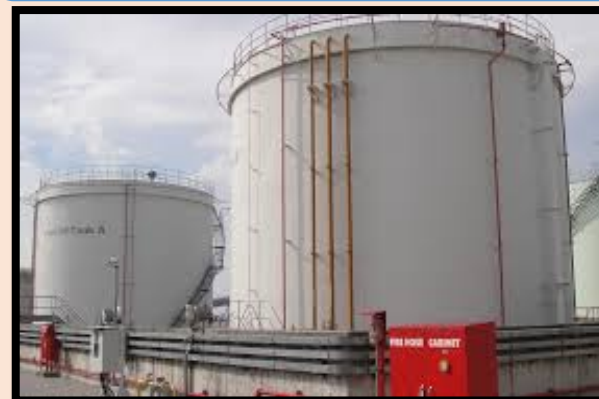
ถังเก็บน้ำมันเชอเพลิงบนดิน
